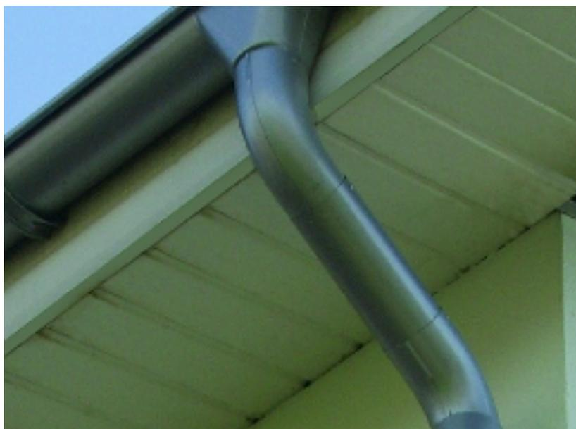
10. При большом расстоянии между водоприемником и стеной, используем колено с трубой необходимой длины.
