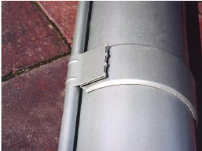
7. Устанавливаем края желоба друг против друга, соединяем их с помощью соединителей желоба и защелкиваем фиксатор.
