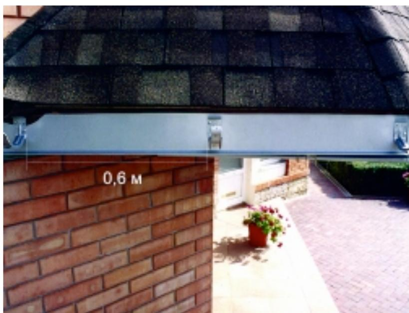
2. Крюки желоба размещаем на одинаковом расстоянии. Максимальное расстояние между крюками 0,6 м.
