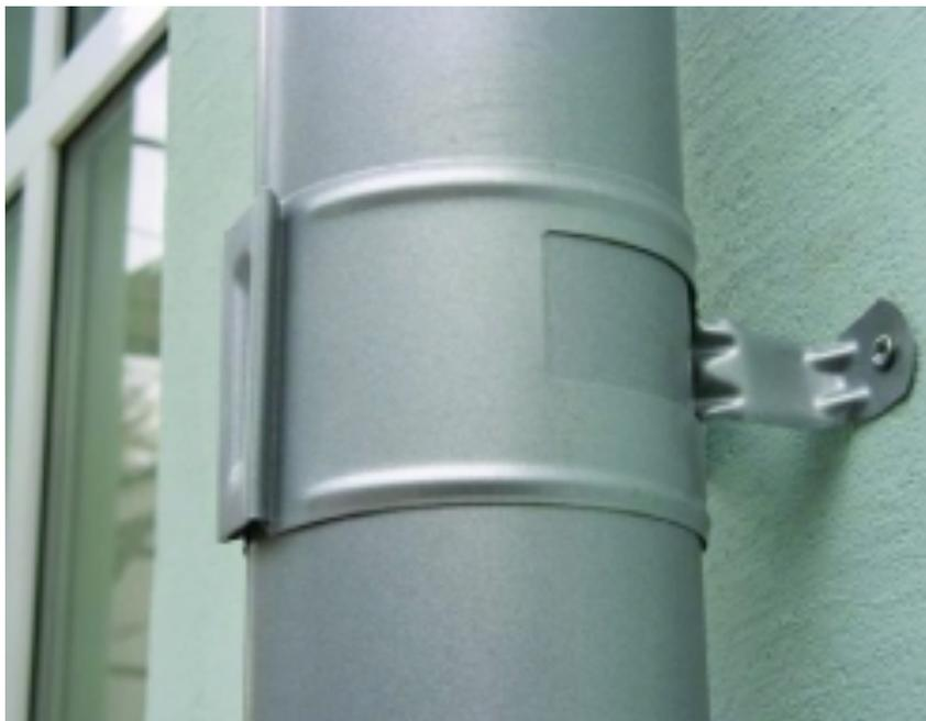
11. Место соединения колена и водосточной трубы крепим к стене при помощи держателя трубы. Максимальное расстояние между держателями составляет 2 м.
