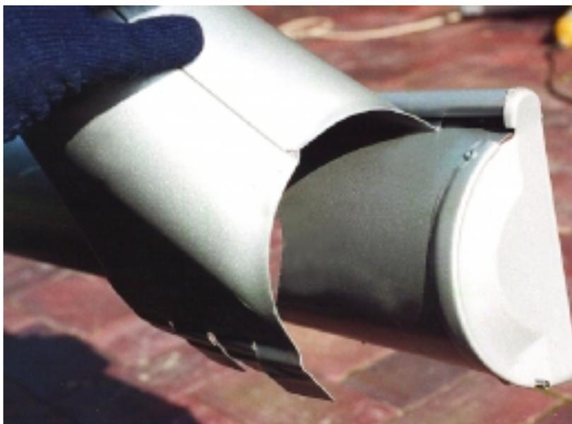
5. Устанавливаем водоприемник на выпиленное ножовкой отверстие. Загибаем язычки вокруг краев желоба. Закрепляем желоб в предназначенных для него крюках круглым краем наружу.
