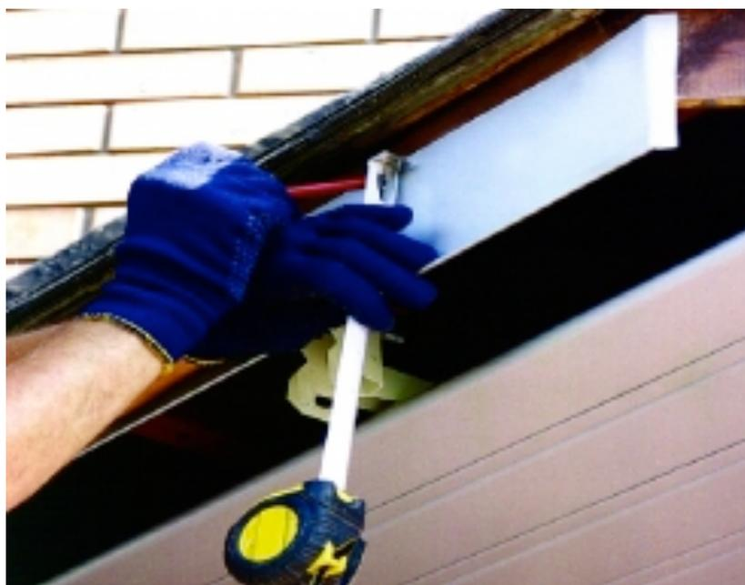
1. Монтаж начинаем с закрепления самого длинного и короткого крюка, между которыми натягивается шнур, обозначающий уклон желоба. Рекомендуемый угол наклона желоба от 2 до 5 мм на 1 погонный метр в сторону водоприемника.
