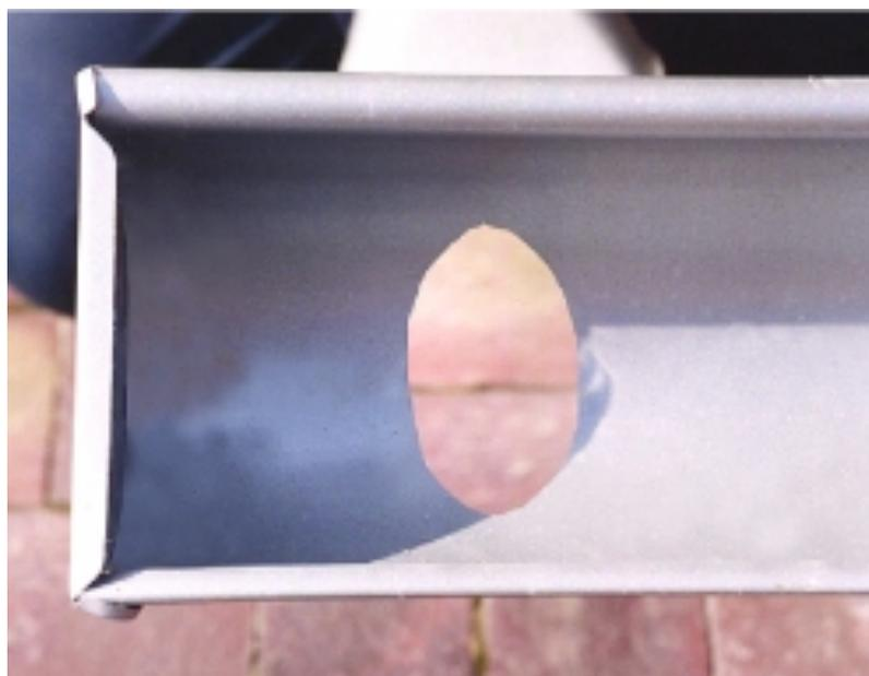
4. Отмечаем расстояние, на котором должен быть установлен водоприемник. Выпиливаем отверстие ножовкой по металлу.
