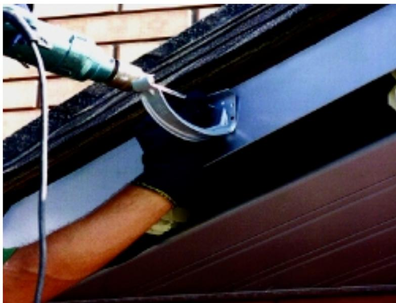
3. Компактный крюк желоба крепим к лобовой доске. Способ монтажа компактных крюков желоба смотрите в пункте 1.
